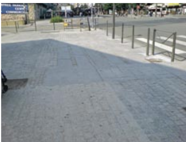
Quand les marches se confondent dans les pavés...
